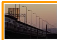
道路・電気設備
